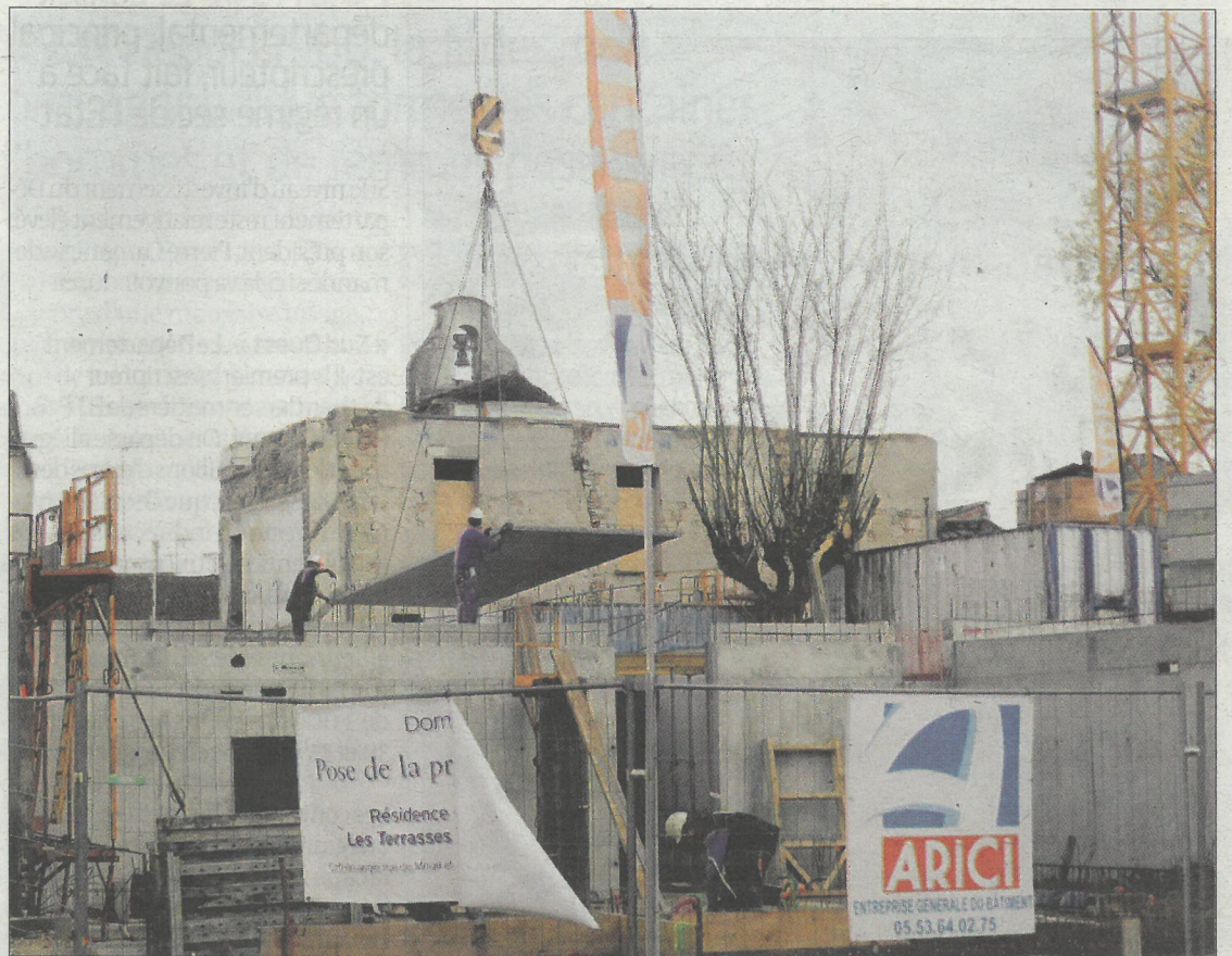
L'entreprise Arici travaille sur d'importants chantiers, principalement en Lot-et-Garonne et en Gironde. PHOTO M. R.
