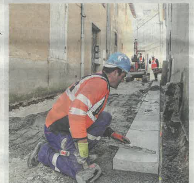
La rue Laffiteau en travaux. Un changement radical à attendre compte tenu de son état précédemment.
